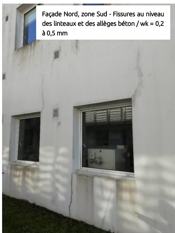
Figure 5 : Photos des désordres observés (1)
