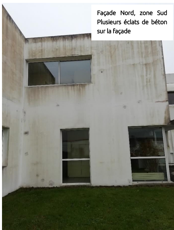
Figure 6 : Photos des désordres observés (2)
